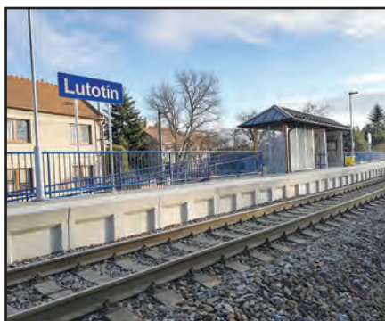
Opravená železniční zastávka
